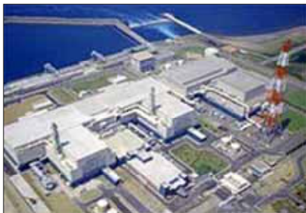
東京電力 柏崎原子力発電所
